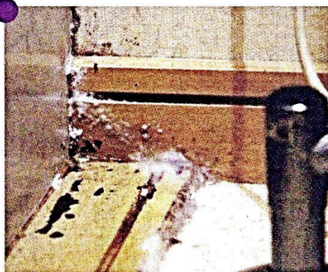
白カビがはえたトイレの床 2月17日、宮城県石巻市の仮設追波川多目的団地(杉山良一さん宅)
